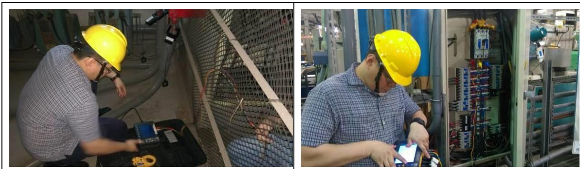
圖 1-3、用電負載狀況掛錶量測
