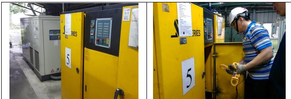
圖 4-2、空壓機單機效率量測
